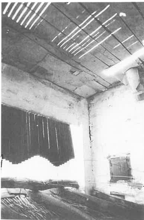
SOLANAR DE CARMEN CRISTOBAL. Puede verse el techo de vigas y cañizos, el suelo de madera y cortina de madera para tapar el sol en verano. (Foto J. Martín)
