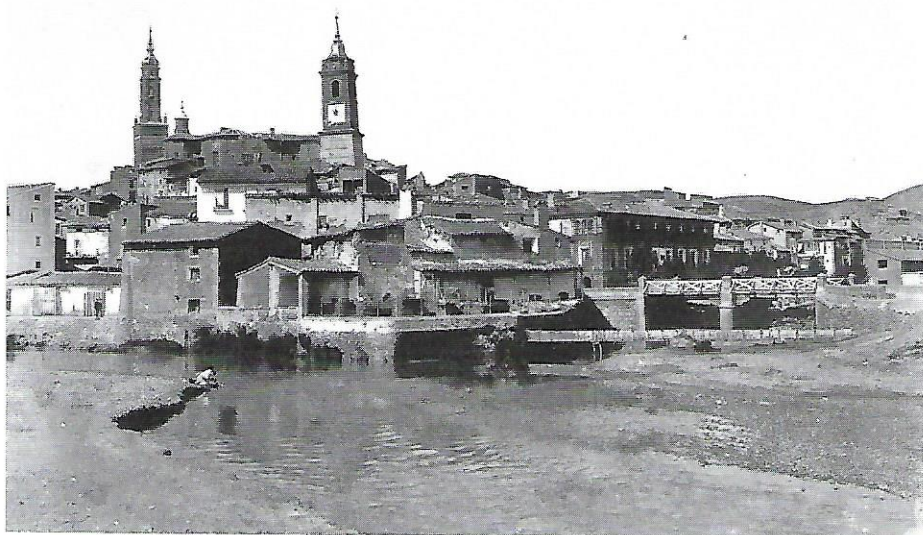
Edificaciones civiles en el vértice del triángulo que marcan los ríos Jalón y Manubles. Obsérvese el puente construido para dar servicio a la carretera Zaragoza-Madrid y el conducto de madera que trasvasa la acequia de Las Canales, mediante un sifón, al otro lado del río. (Autor fotografía: HUESO. Original cedido por Jesús Blasco).
